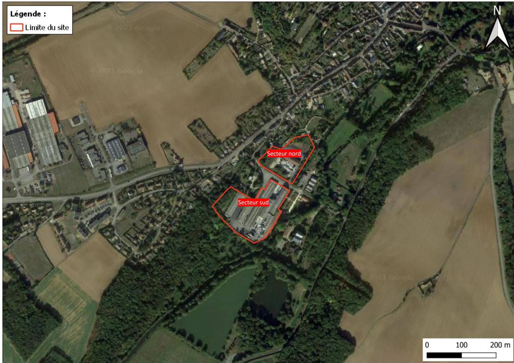
FIGURE 2 : VUE AERIENNE DU SITE
